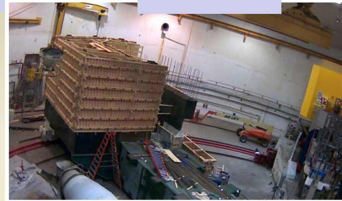
Shield House Wall Pour (JLab)
